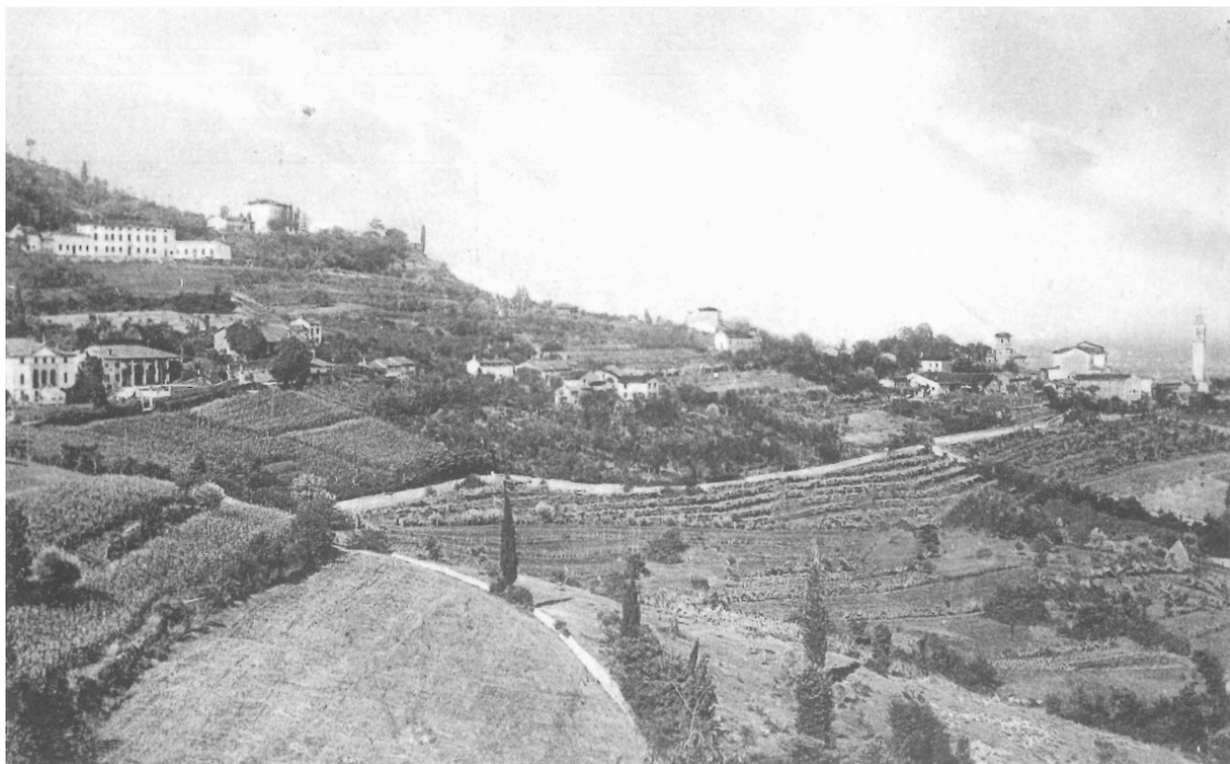
1930: Collina lato ovest Via Pozzetto, il viottolo e le mura della Bastiana che porta in Piazza Roma. Sulla sinistra villa Suppiej, villa Del Sole e villa Fanton Miari Favretto.
