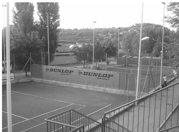
I due campi da Tennis in terra
